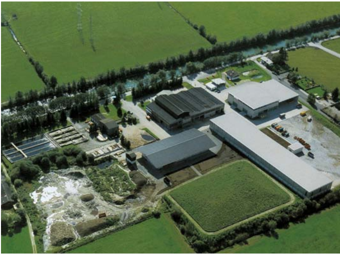
Abfallbehandlungsanlage mit angrenzender Kläranlage / Waste treatment plant with bordering composting plant
