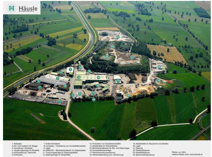
Abfallwirtschaftszentrum Lustenau-Königswiesen / Aerial view of the waste management centre Lustenau-Königswiesen
