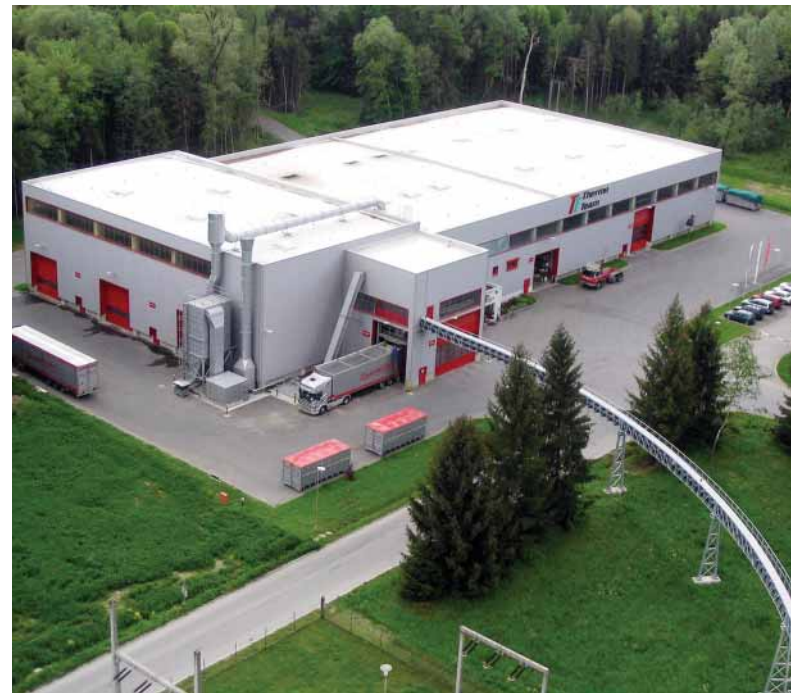
Herstellung von Ersatzbrennstoffen für die Zementindustrie in Retznei, Österreich / Herstellung von Ersatzbrennstoffen für die Zementindustrie in Retznei, Österreich
