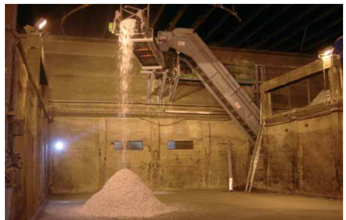
Erste Charge nach dem Umbau / First charge after the modification
